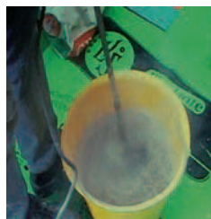
Preparazione del collante con adesivo Geolis 3.5 NHL
