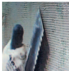
Applicare la rete in fibra con una rasatura a turapori leggera con adesivo Geolis 3.5 NHL
