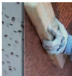
Posa dei pannelli sulla superficie piana. Piccozzare e battere accuratamente
