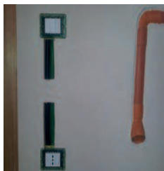
Tracce incassate nel pannello
