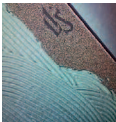
Spalmatura del collante con spatola dentata da 7-10 mm lato grana fine
