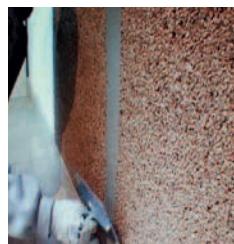
Stuccatura delle giunture con adesivo Geolis 3.5 NHL. Controllare la planarità
