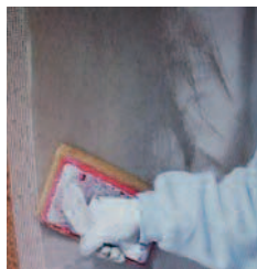
Finitura con intonaco con Naturalis 3.5 NHL. Non posare spessori superiori a 2-3 mm
