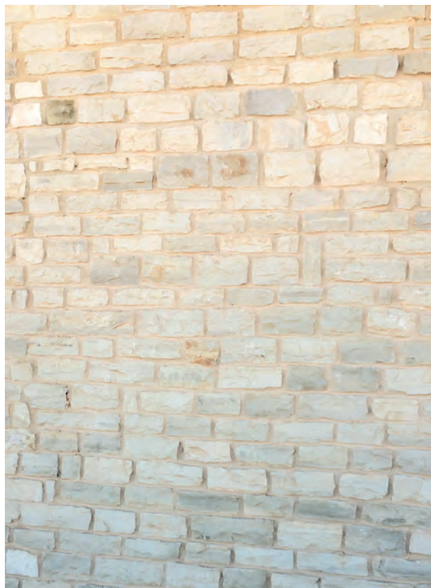
Rivestimento con listelli in pietra di Trani
