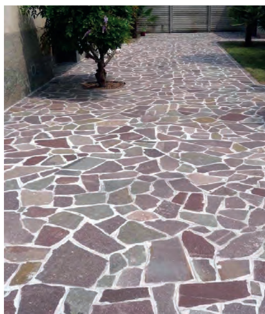
Pavimentazione in porfido del Trentino
