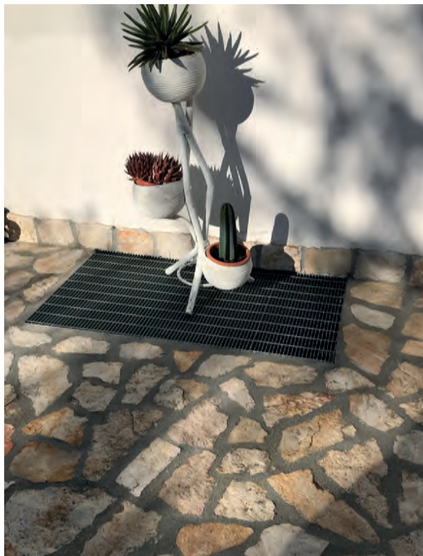
Pavimentazione scorza in pietra di Trani
