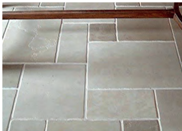
Pavimento in Pietra di Trani opus romano spazzolato
