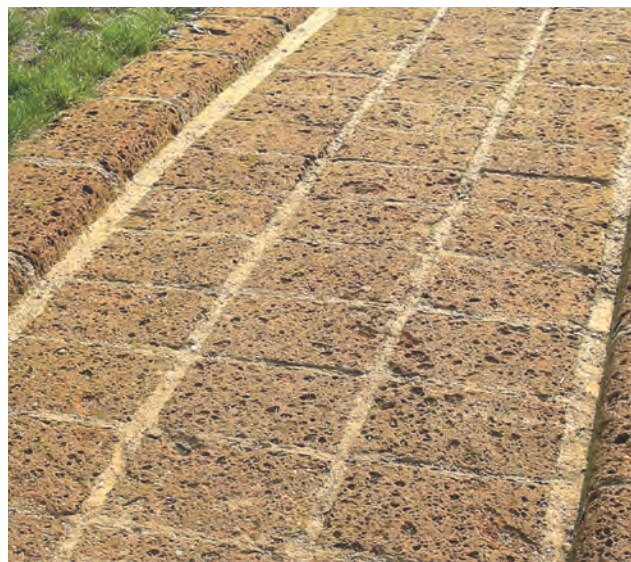
Pavimentazione in tufo romano
