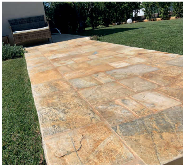
Pavimentazione in basola Alba
