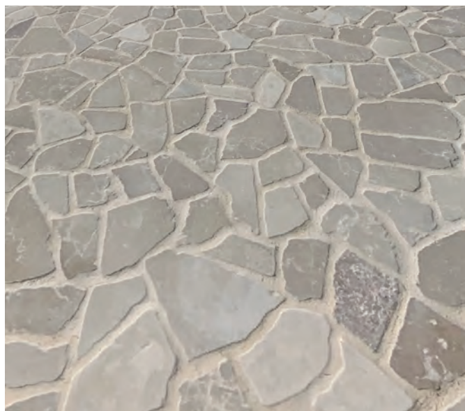
Pavimento in palladiana in pietra di Trani anticata
