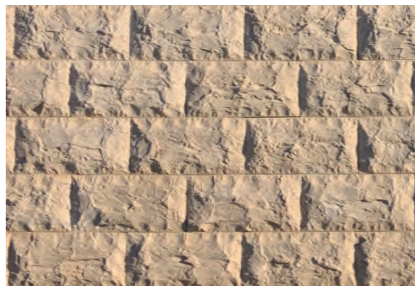
Rivestimento in bolognino in pietra di Trani
